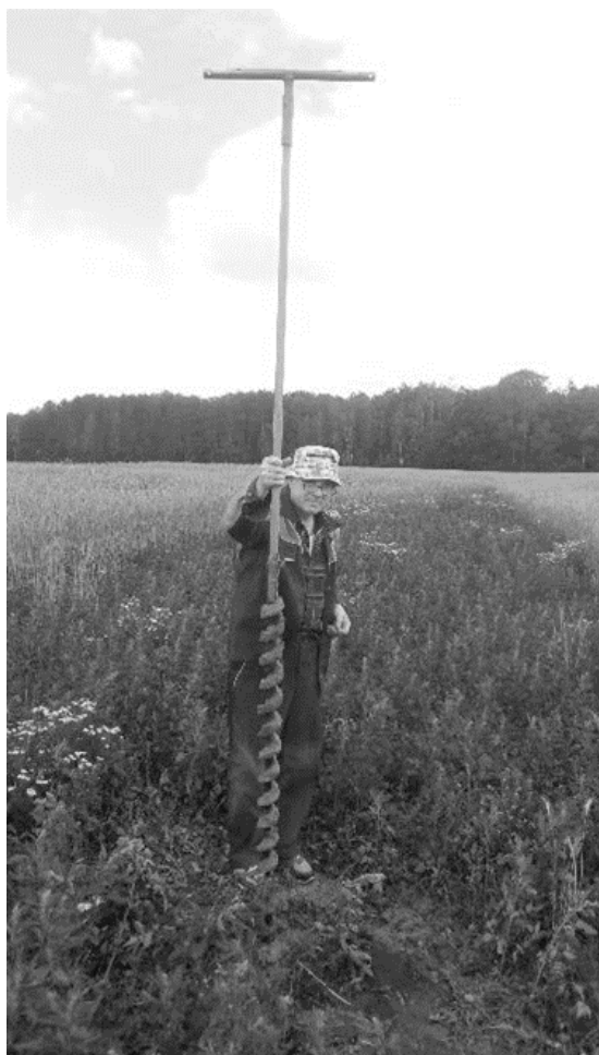
Рисунок 3 – Обустройство скважин для отбора грунтовых вод при помощи бура со шнековым механизмом удаления грунта
